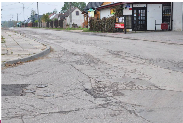
ul. Południowa przed przebudową
